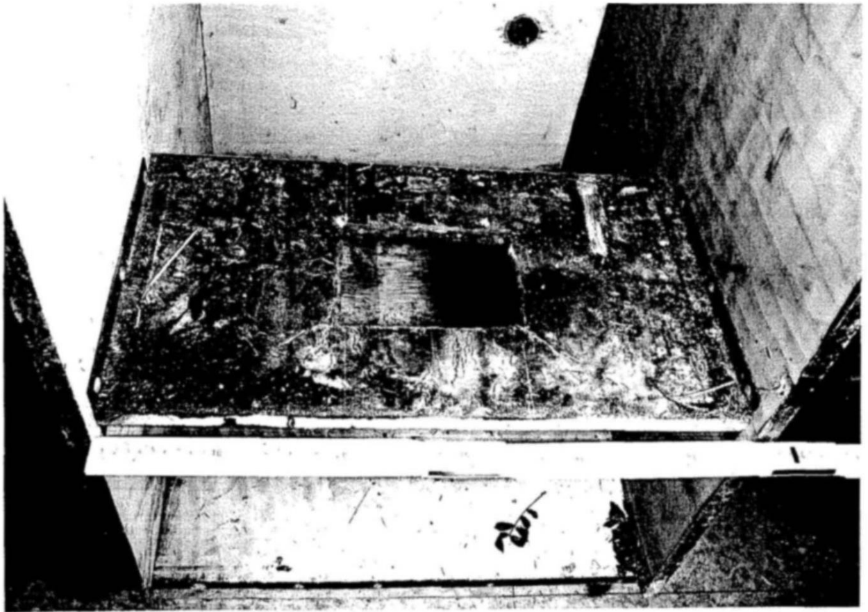
Aufnahme von der Sitzbrettoberseite und dem unteren Bereich des Innenraumes
